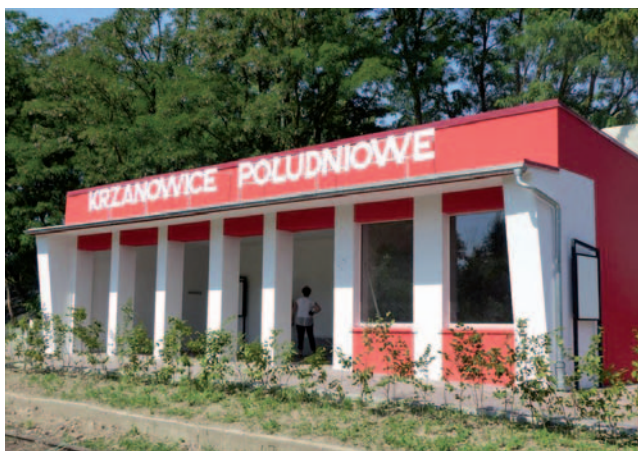
Przebudowa zniszczonego, nieużywanego budynku dworca kolejowego w Krzanowicach pozwoliła na stworzenie jednego z miejsc odpoczynku na szlaku Lichnowskich.
