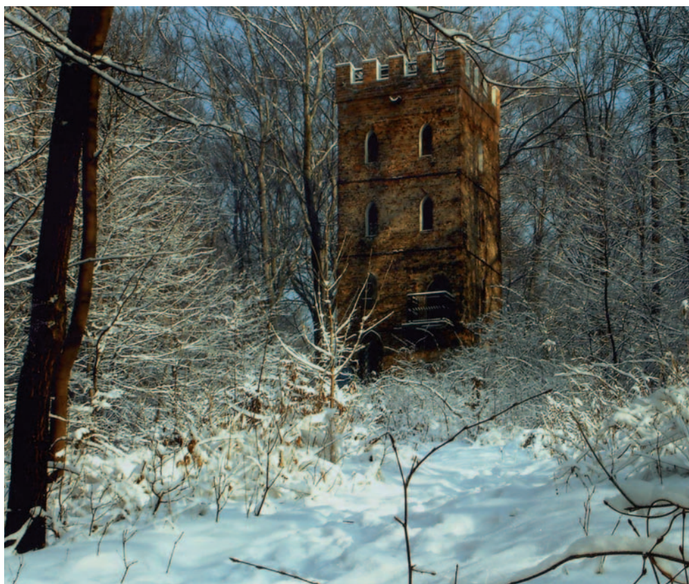
Baszta Rycerska w Wodzisławiu Śląskim zostanie udostępniona turystom po modernizacji zaplanowanej na lata 2020-2021.
