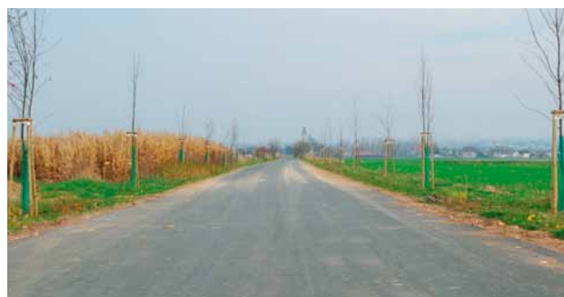
Droga Trębom-Kietrz przed, w trakcie i po budowie
